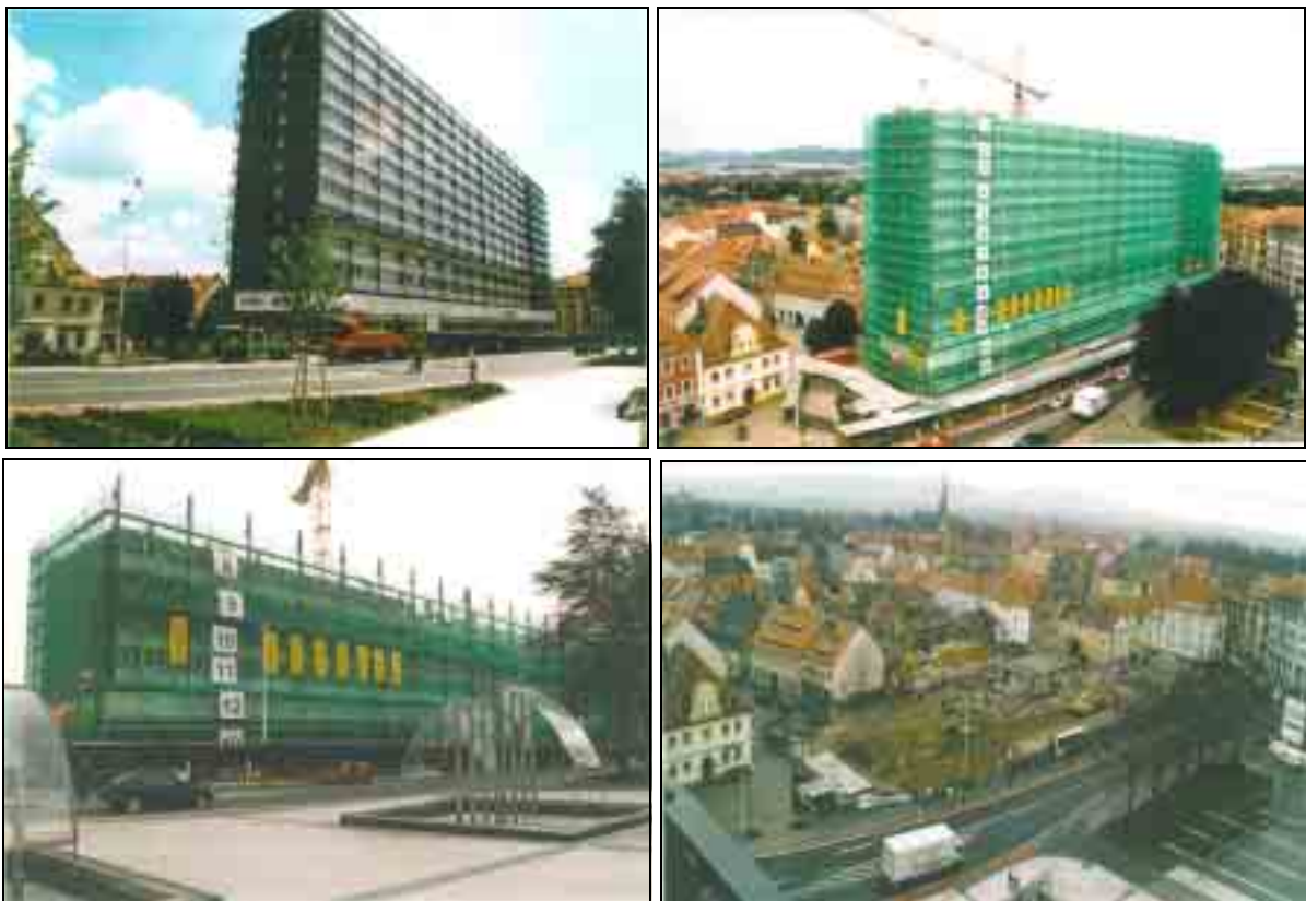
Abb. 12: Rückbau des Hochhauses am Bautzener Kornmarkt (Herbst 1999 bis Frühjahr 2000) Quelle: Stadt Bautzen
